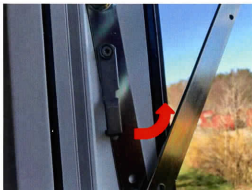
"Extra" putsbeslag i ej spärrat läge.
