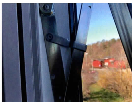
"Extra" putsbeslag i spärrat läge
